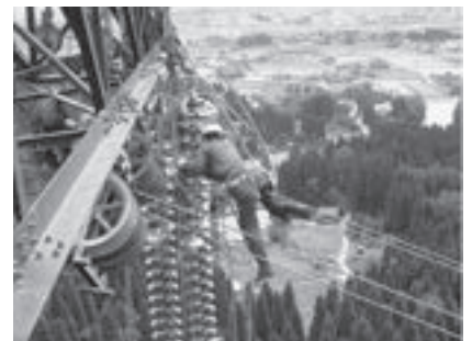
送電線上での作業風景
